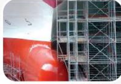
Reparación de Buques
