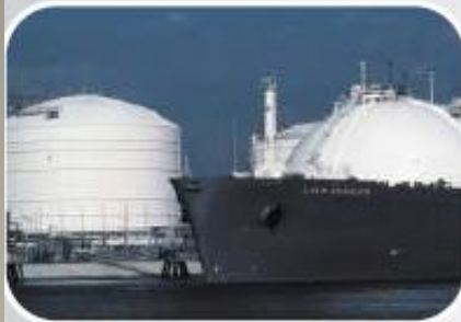
Terminal de LNG
